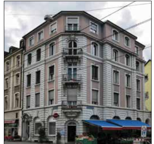
Klybeckstrasse 101, Baujahr 1902. Foto: Mietshäuser Syndikat Basel
