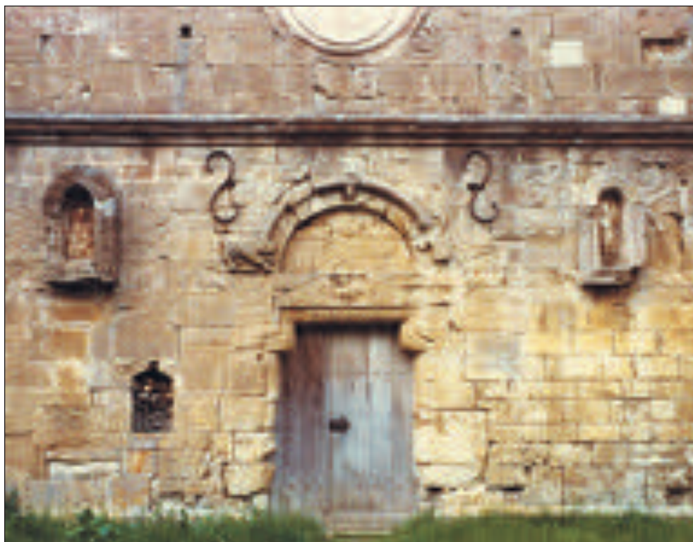
Das romanische Hauptportal vor der Restauration um 1980.
