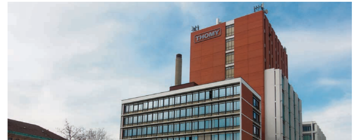
Markanter Industriebau Thomy & Franck AG (Fotos: Matthias Brüllmann)
