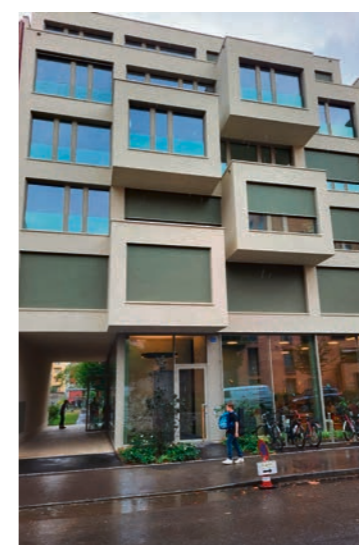
Das neue Haus der Stadtmission am Giessliweg.
